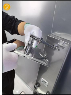
2 Anslut den övre spraysen och vattenutloppsarmen gemensam.
