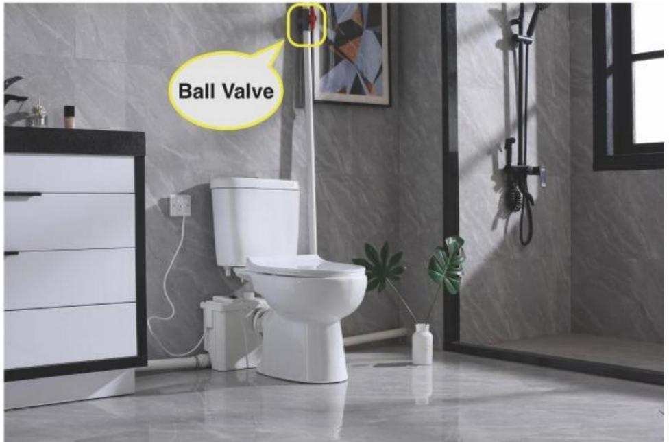
(5-4) Bitte installieren Sie einen Kugelhahn (nicht im Lieferumfang enthalten) in der Nähe des Wasserauslasses, um ein Austreten von Abwasser zu verhindern, wenn die Pumpe zerlegt wird.
