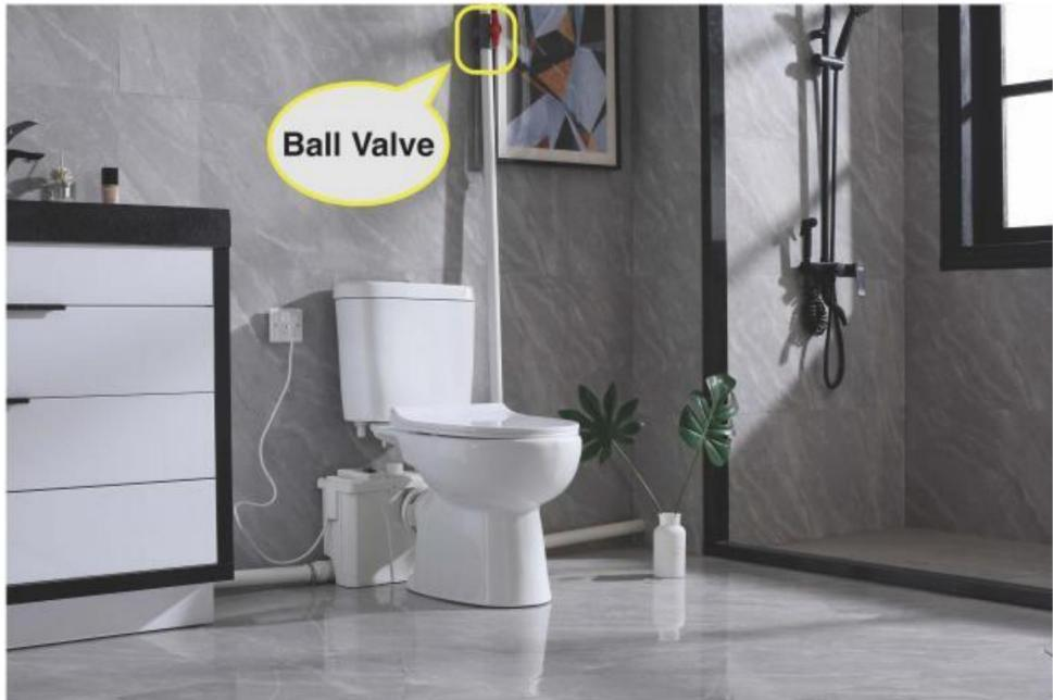
(5-4), Veuillez installer un robinet à boisseau sphérique (non fourni) près de la sortie d'eau pour éviter les fuites d'eaux usées lorsque la pompe est démontée.
