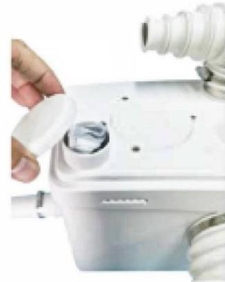
Schéma 2 : ouvrez le couvercle, placez le tuyau coupé (F) sur l'orifice du charbon actif et fixez-le avec un collier de serrage (M) (32-50 mm). L'autre extrémité est reliée au tuyau d'échappement, dont la taille est de 40 mm.
